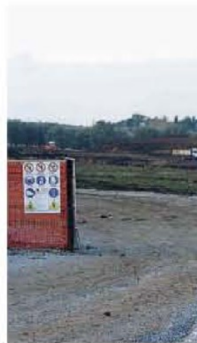
Il cantiere. Si partirà in ottobre
